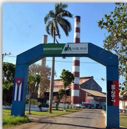
Figura 10. Arco de entrada del central 14 de Julio, Cienfuegos, 2022
