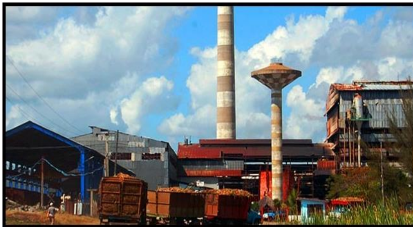
Figura 9. Central Batalla de las Guásimas (Vertientes, Camagüey), que comenzó a fomentarse en 1977 (2015)
