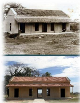
Figura 14. Imágenes de la restauración de la casa del mayoral del ingenio Triunvirato, 2014-2015
