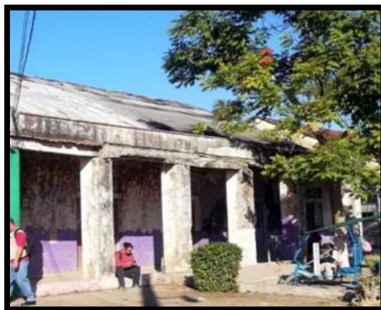
Figura 39. Bodega y taller de reparación de calzado del batey Toledo (2033)
