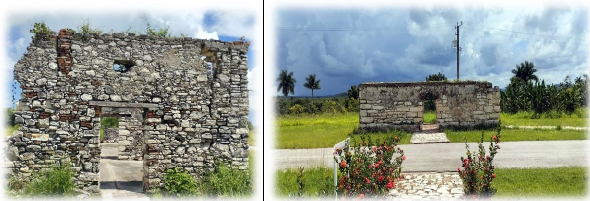
Figura 18. Ruinas de los antiguos barracones (izquierda) y de la enfermería del ingenios Triunvirato, 2022
