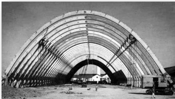
Figura 11. Almacén de azúcar a granel en construcción con elementos prefabricados de hormigón, c 1950
