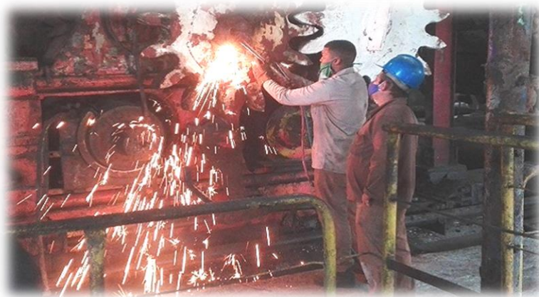
Figura 13. Reparaciones en el central 14 de Julio antes de la zafra de 2023, 2022
