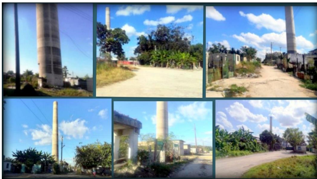
Figura 7. Casas construidas en el área de la chimena del central Toledo (2023)
