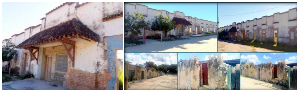
Figura 8. Fachada y muro de los barracones del central Toledo desde distintos ángulos y nivel de detalle (2023)
