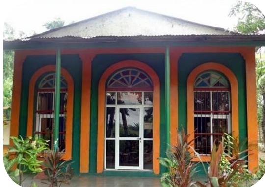
Figura 19. Casa del intendente del central Manuelita, actualmente sala donde se muestra la historia del ingenio, 2023
