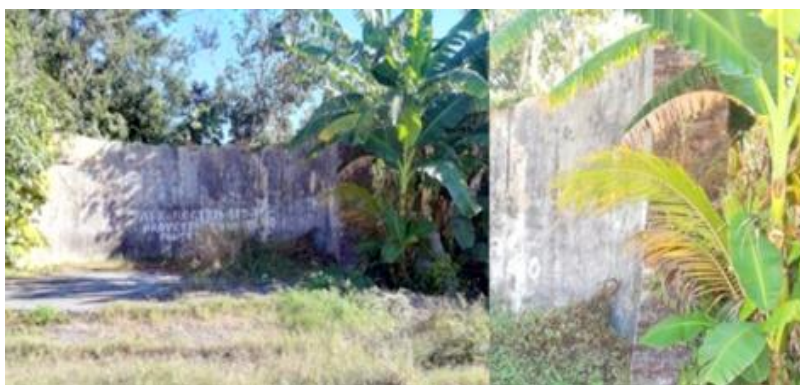
Figura 29. Vestigios que quedan de un tanque circular del central Toledo y detalle de su pared (2023)
