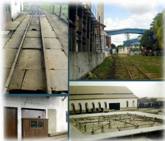
Figura 22. Piscina de tratamiento de aguas del central Manuelita, c 1915, romana de su ferrocarril (izquierda) y sus vías y tanques en el lateral del ingenio actualmente, 2023
