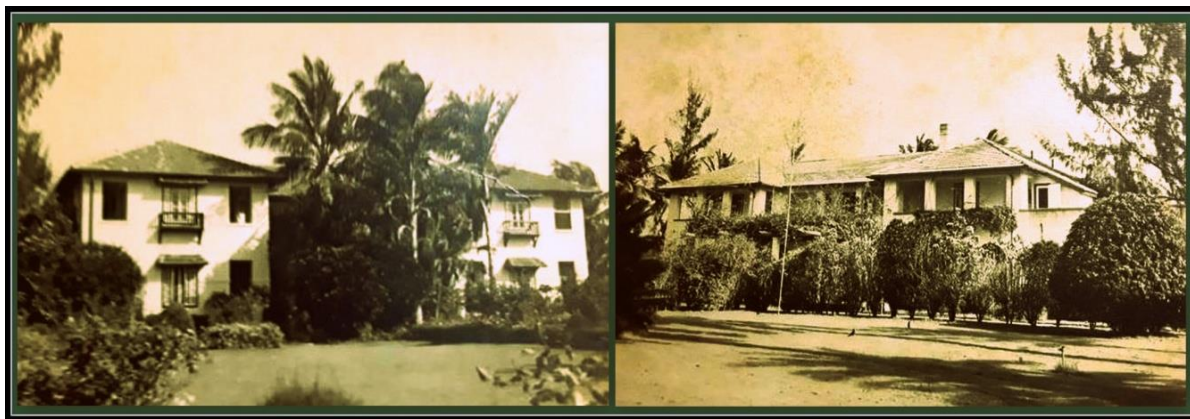
Figura 22. Casona del Punta Alegre, entrada y fachadas delantera y trasera (derecha) c 1950
