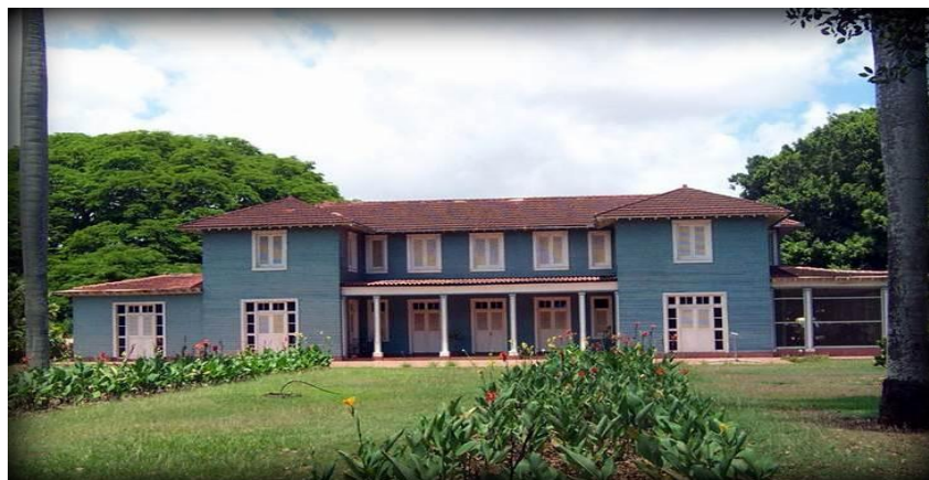
Figura 8. Casa del administrador del central Cunagua, actualmente Bolivia, construida en 1918
