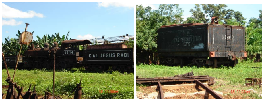
Figura 3. Locomotora de vapor centenaria 1414 del central Jesús Rabi en pésimo estado de conservación actual. Matanzas, 2023
