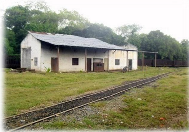
Figura 4. Ferrocarril del central Manuelita y edificio de su romana, 2023
