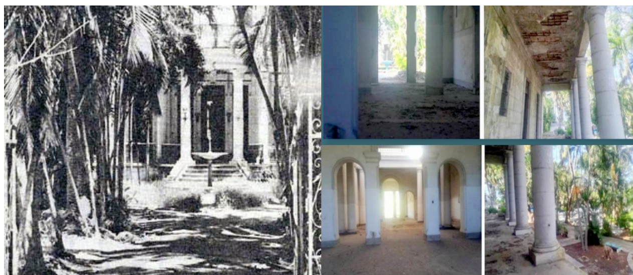
Figura 20. Casa Blanca , vivienda de Manuel Aspuru en el central Toledo hacia 1980 y muestras de su deterioro y el vandalismo que ha padecido (2023)
