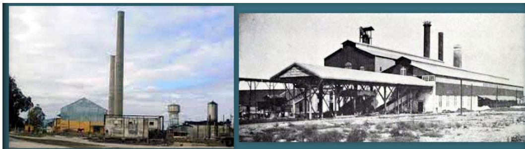
Figura 7. Centrales La Vega y Toledo, construidos o remodelados en acero, Cuba, c 1940 y 1920
