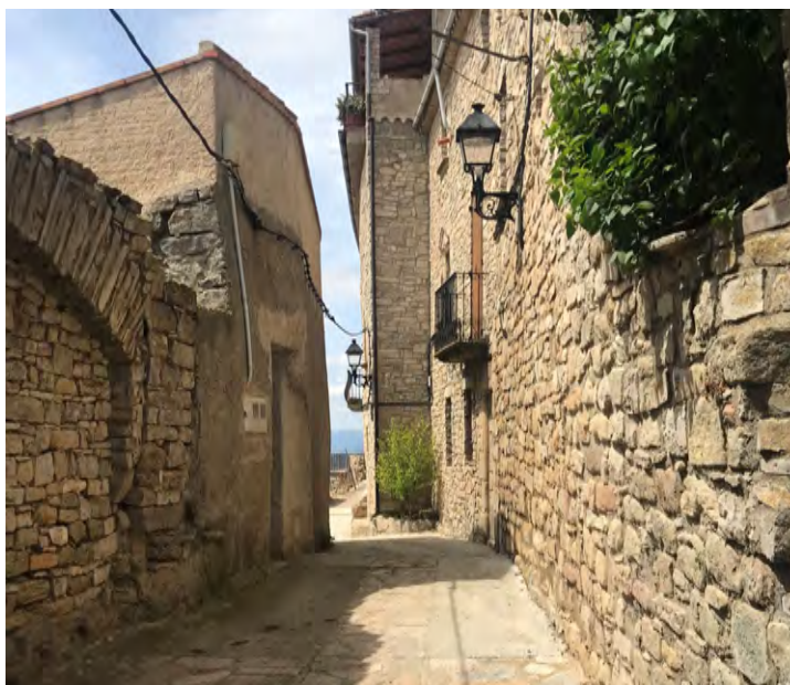
Figura 10. Calle de Forès que muestra una buena mezcla de construcciones de hoy, ayer, y anteayer.
