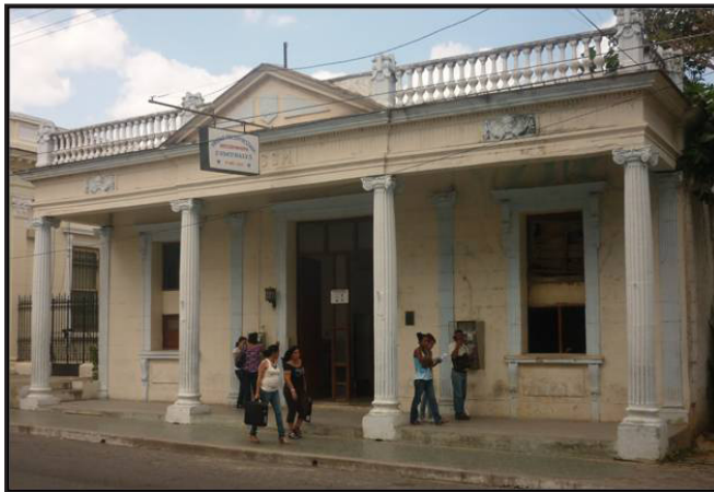
Antigua Casa de Socorro donde radica actualmente la Dirección de Servicios Comunes en el municipio de Pinar del Río.
