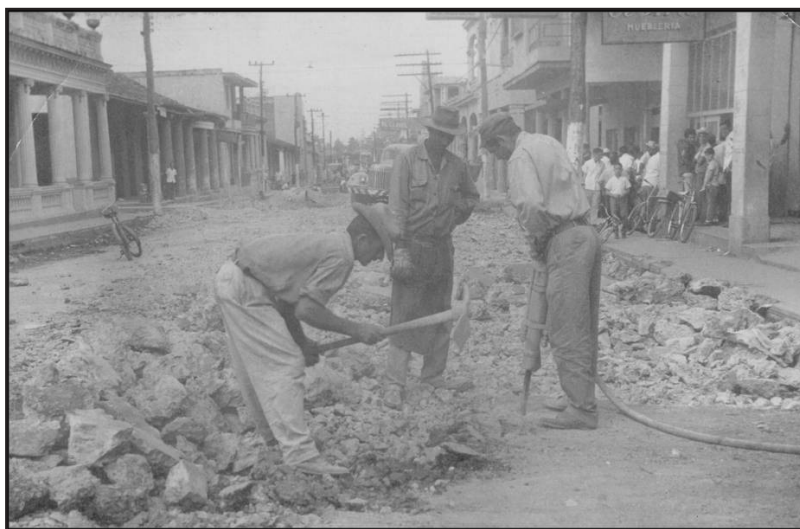
Calle Vélez Caviedes en construcción.
