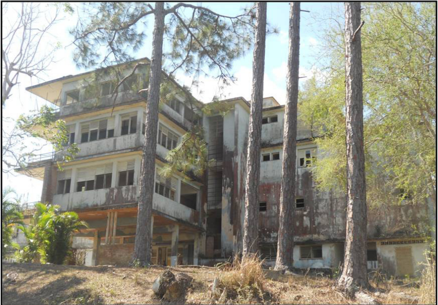
Arriba: vista del hospital antituberculoso cuando se levantaba la tercera planta (1954-1955). Abajo: vista actual del hospital que permanece en ruinas.
