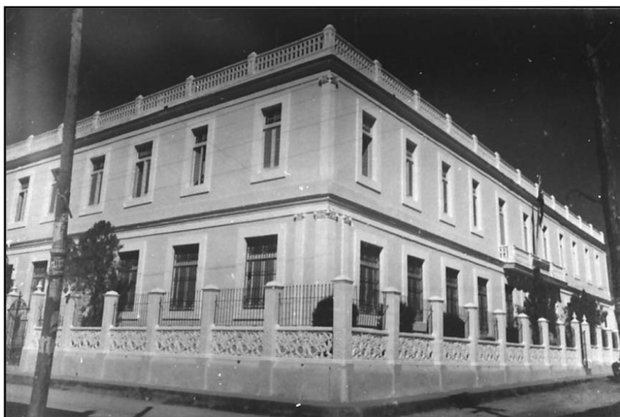
Vista exterior del gran edificio que ocupó el Colegio de los Reverendos Padres Escolapios, en la esquina de las calles Rosario y Virtudes.
