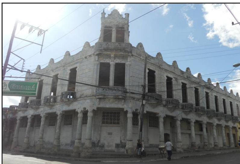
Vista anterior y vista actual del antiguo Hotel Comercio situado en la esquina de las calles Vélez Caviedes y Martí.
