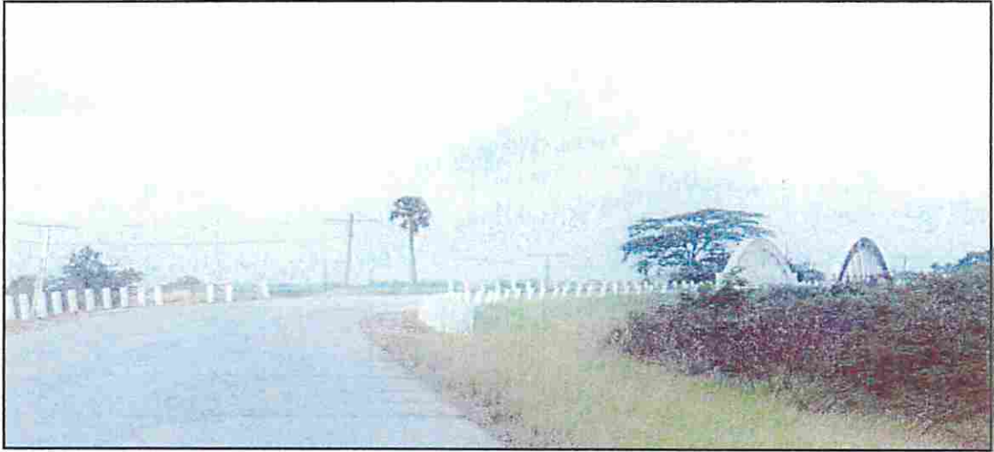
Un puente en la Carretera Central
