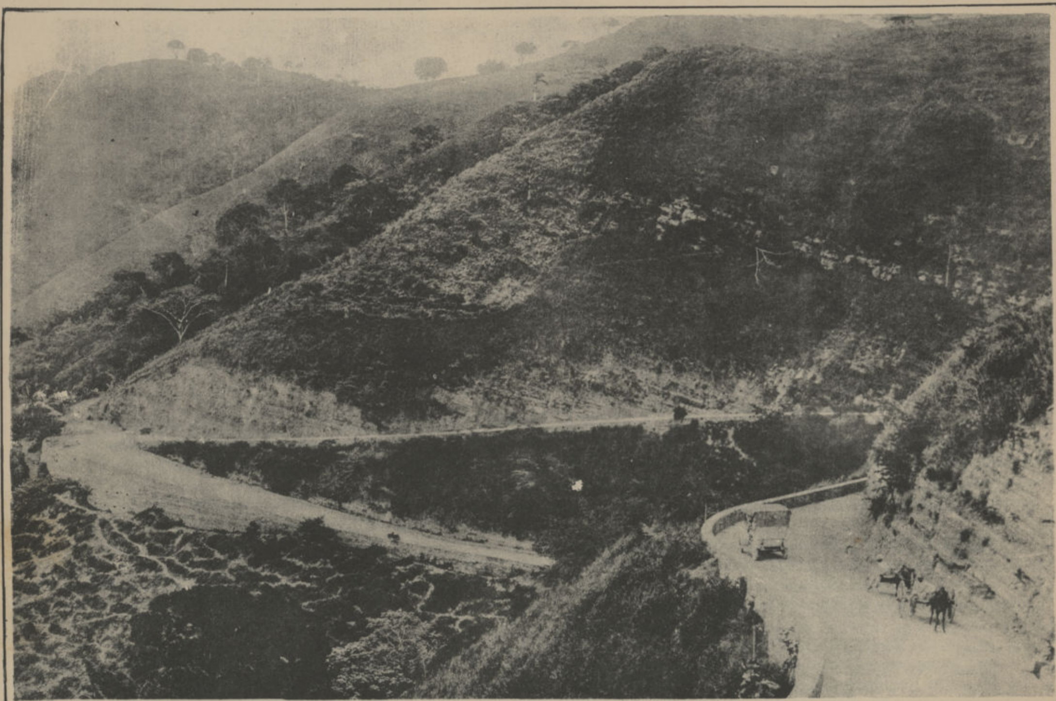
CARRETERA PUERTO BONIATO, ORIENTE.
