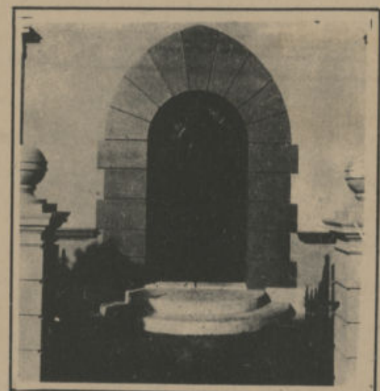
Detalle de la puerta principal.
