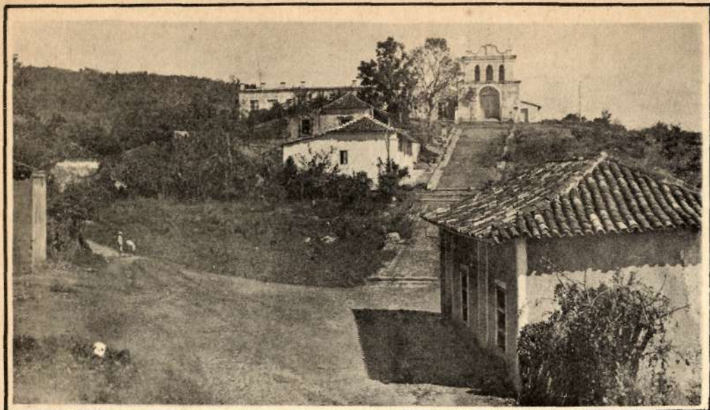
LA HERMITA DE "LA POPA" EN TRINIDAD. Antigua edificación que sirvió en tiempo de los españoles como hospital, luego como cuartel e iglesia, que se halla hoy en ruinas.
