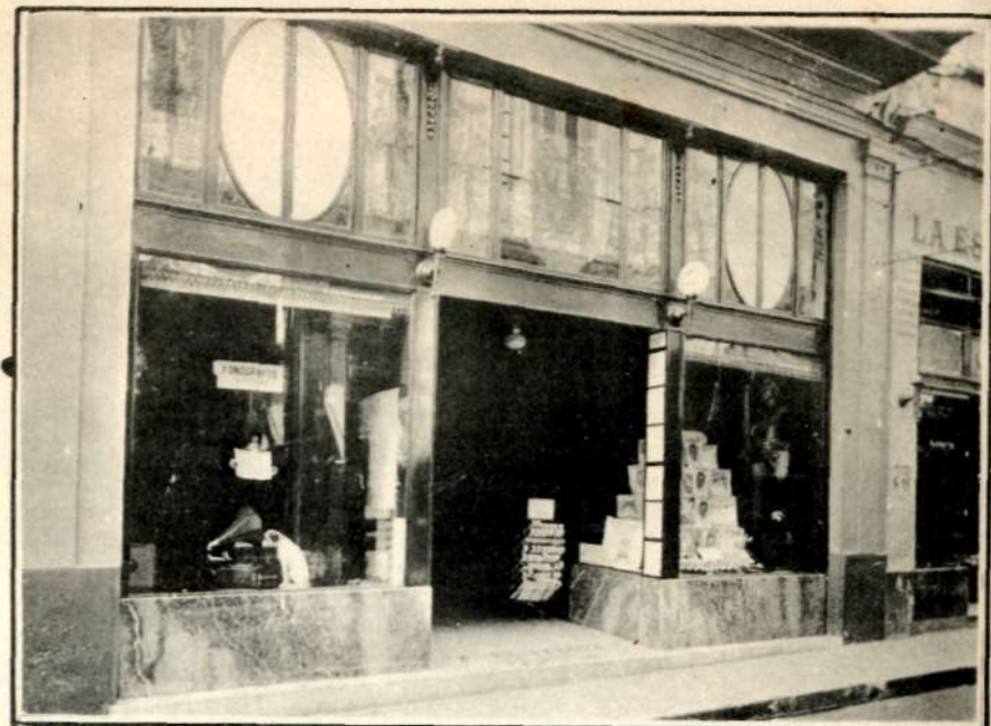
La fachada de O'Reilly
