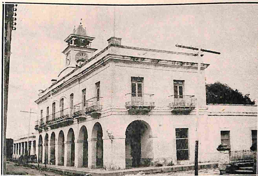
Una vista general exterior del edificio del Ayuntamiento de Bolondrón.
