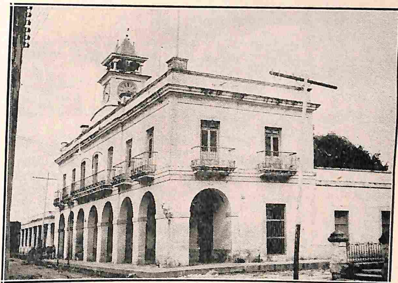
Una vista general exterior del edificio del Ayuntamiento de Bolondrón.
