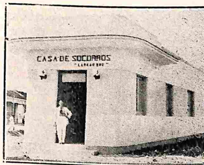
CASA DE SOCORROS "LAREDO BRU" EN LOS ARABOS
