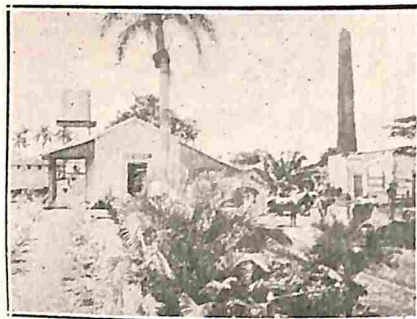
Un aspecto exterior de la casa oficina.
