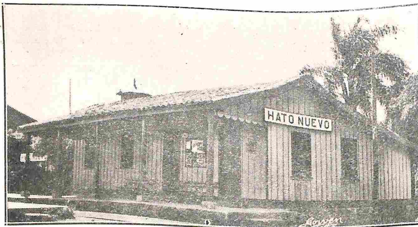
Hato Nuevo, así reza en la Estación de los Ferrocarriles Unidos de la Habana, en el pueblo de Martí, por censurable apatía.
