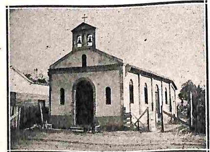
De reciente construcción, la Iglesia Episcopal del Barrio de Lacrete
