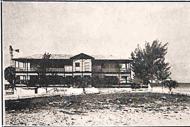
Exterior de "La Casa Portilla".
