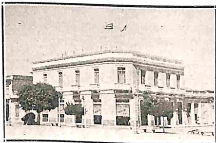
Edificio que ocupa la exposición de la casa E. Silva y Giquel, en Cárdenas.
