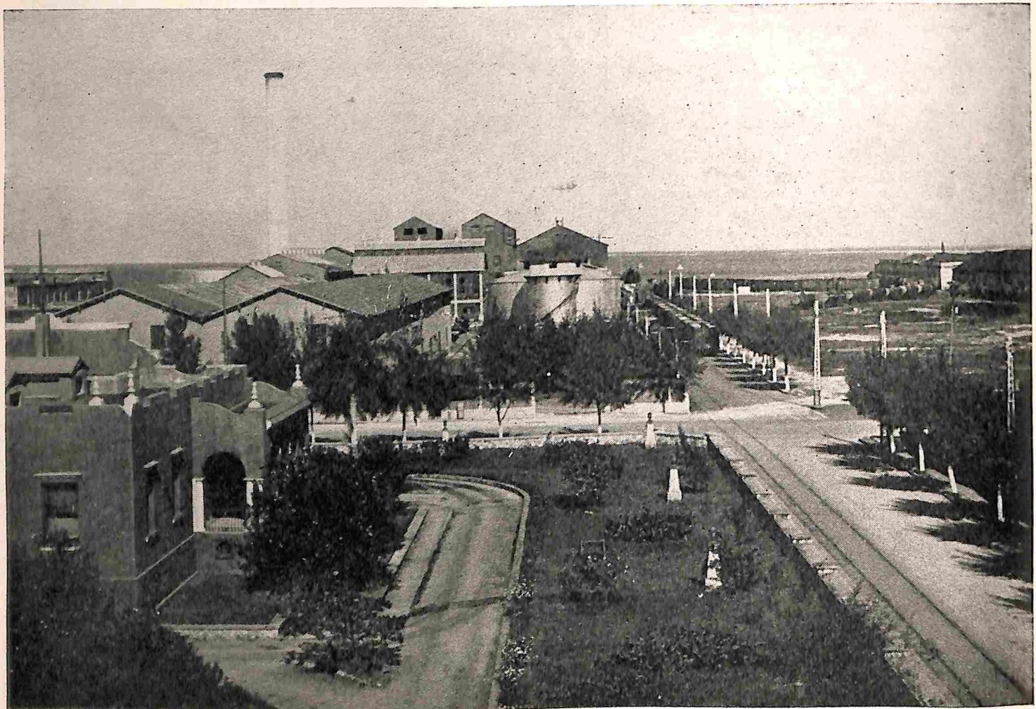
El agradable ambiente que rodea la industria, hace más majestuosa esta vista parcial de la entrada de la misma, tomada de un ángulo sur del edificio de las oficinas generales.
