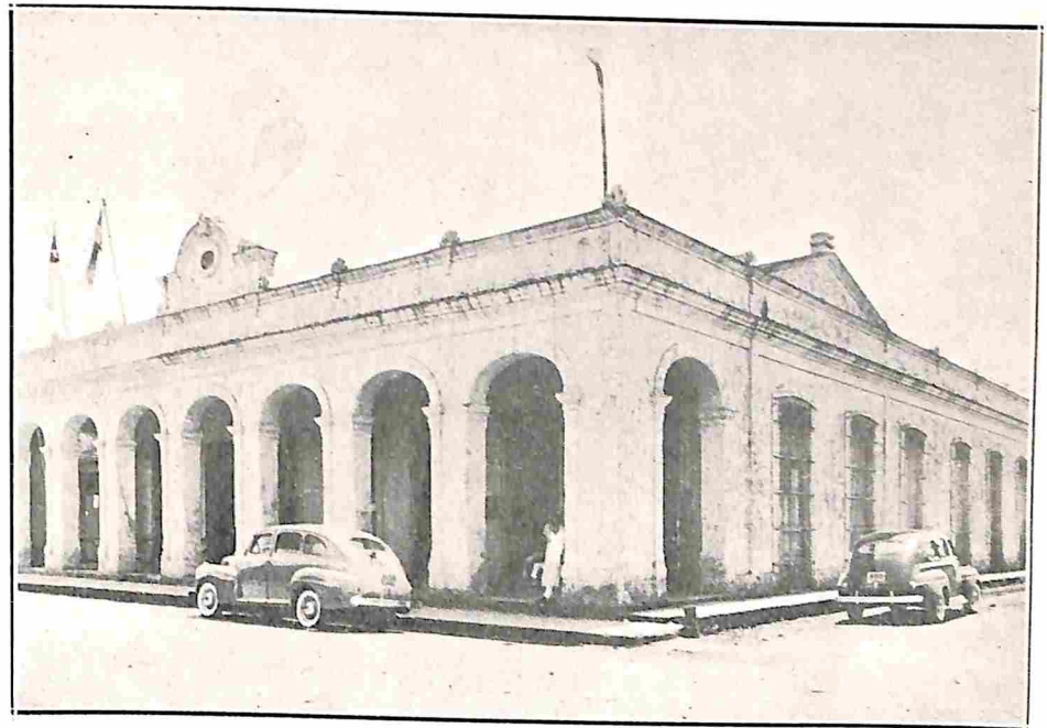
Aspecto exterior de la Casa del Pueblo.
